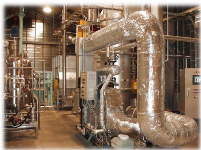
<バイオマスボイラー> 東京大学生産技術研究所
